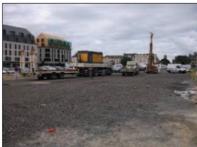
Figure 2 : Etat du site en septembre 2010
